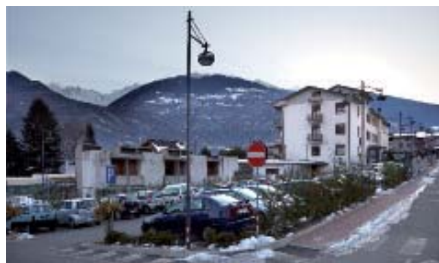
L'area dopo i lavori di riqualificazione.
